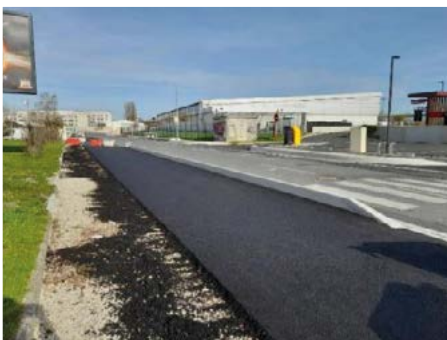
Travaux zone ADELIS.
