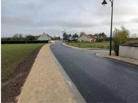
Travaux rue de la Folie.
