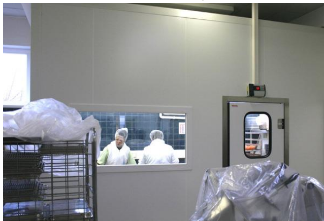
Réalisation d'une chambre froide à la restauration municipale
