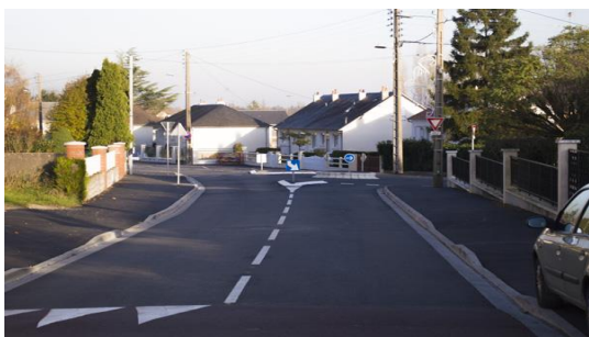
Travaux rue de la Justice
