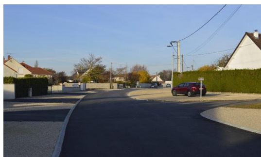
Travaux en régie de la rue de Changelin
